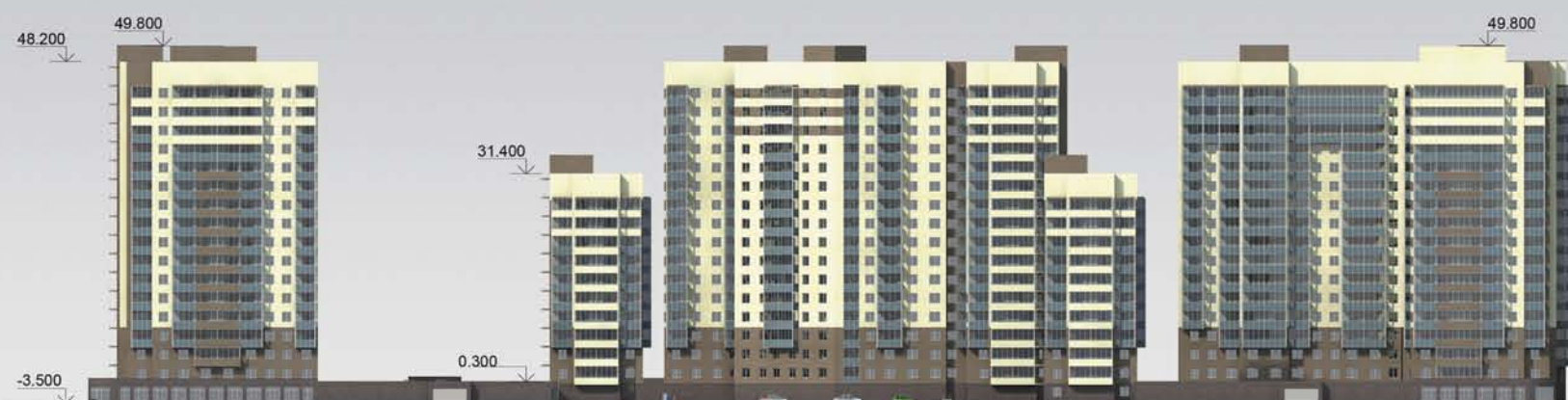
Фасад комплекса со стороны стадиона
